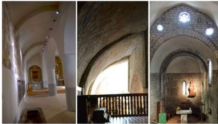
Fig. 17. Convex funicular vaults in Santa Eularia d'Unha, Santa Maria d'Arties and Era Purificacio de Bossost.
