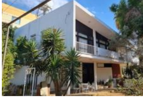
Fig. 7: Desaini Aalotar- Ertoğrul Güven House, Köşklüçiftlik Source: Aydınli, 2023
